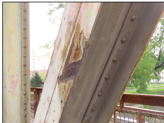
foto č. 6 - L. HL. N. mezi 4. a 5. svislicí - deformace
