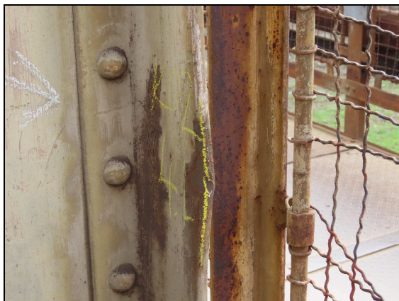
foto č. 5 - L. HL. N. 4. svislice - deformace
