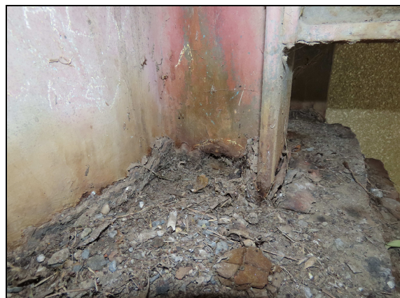
foto č. 1 - horní pásnice podélníku - vytlučené pod mostnicí foto č. 2 - vnější svislá výztuha L. HL. N. nad O 01 - otvor
