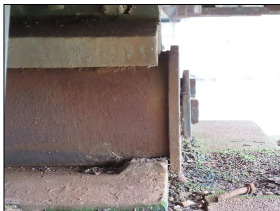
foto č. 8 - K 02 levé ložisko na P 02 - posunutý válec
