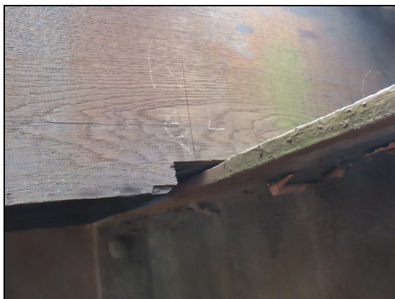
foto č. 1 - horní pásnice podélníku - vytlučené pod mostnicí foto č. 2 - vnější svislá výztuha L. HL. N. nad O 01 - otvor
