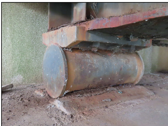
foto č. 14 - levé ložisko na O 02 - posunutý válec
