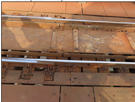
foto č. 15 - K02/K03 - chybějící podkladnice, vrtule
