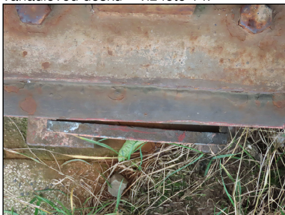
foto č. 13 - pravé ložisko na O 02 - zkřížení
