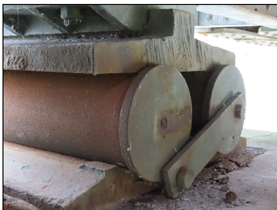
foto č. 7 - K 02 pravé ložisko na P 02 - ustřižený šroub
